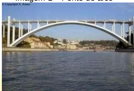
Imagem 1 – Ponte de arco
